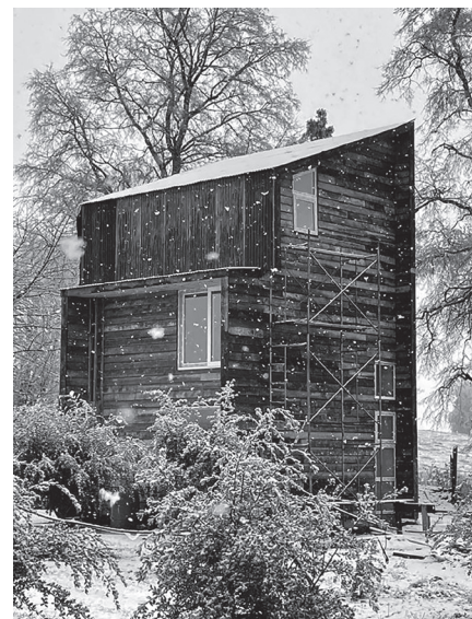
Figura 3. Vista nororiente. Fotografía, Carmen Domínguez.
