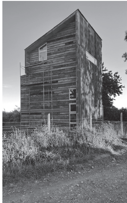
Figura 15. Vista norponiente. Fotografía, Rodrigo Aguilar.
