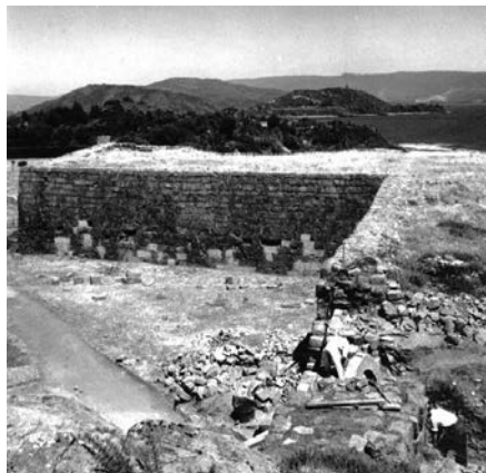
Figuras 1-2. Restauraciones en el Fuerte de Niebla en la década de 1950'. Se observa excavaciones y reconstrucción de muros de la fortificación, los que se edificaron hasta la máxima altura encontrada, de 1 mt.
