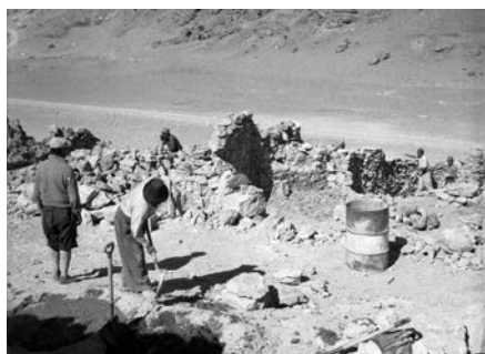
Figuras 3-4. Obras de restauración en el Pukará de Lasana en la década de 1950'. Durante los trabajos se realizó despeje y obras de reconstrucción de muros hasta una altura media, permitiendo la lectura de la planta general.
