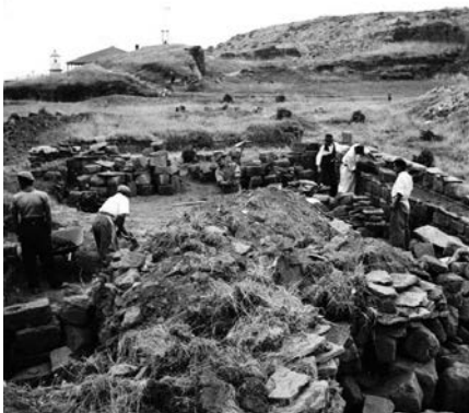
Figuras 1-2. Restauraciones en el Fuerte de Niebla en la década de 1950'. Se observa excavaciones y reconstrucción de muros de la fortificación, los que se edificaron hasta la máxima altura encontrada, de 1 mt.
