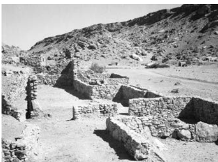
Figuras 3-4. Obras de restauración en el Pukará de Lasana en la década de 1950'. Durante los trabajos se realizó despeje y obras de reconstrucción de muros hasta una altura media, permitiendo la lectura de la planta general.
