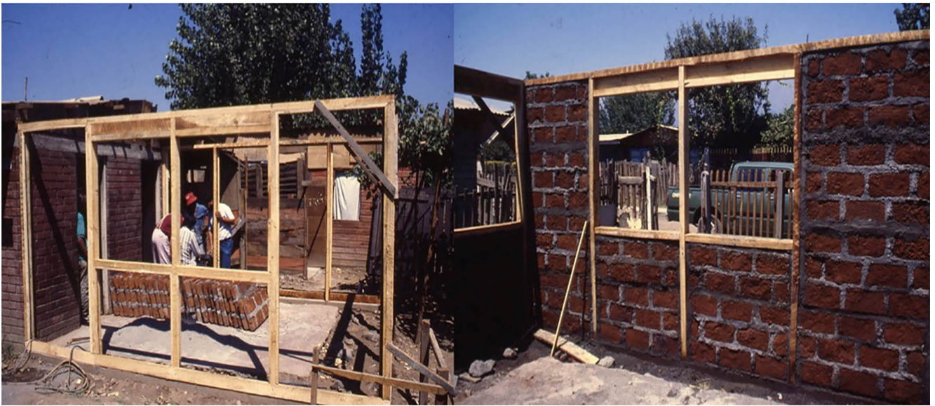
Figura 6. Proceso de montaje de muro LAD-MA.
