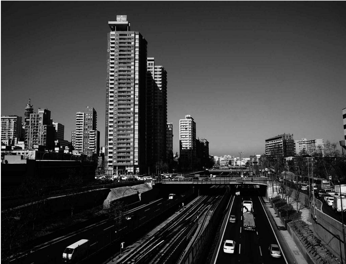
Fig. 4: La avenida Norte - Sur es la expresión del protagonismo de la obra pública presente en el urbanismo de escala metropolitana, desvinculado de un proyecto de ciudad.
